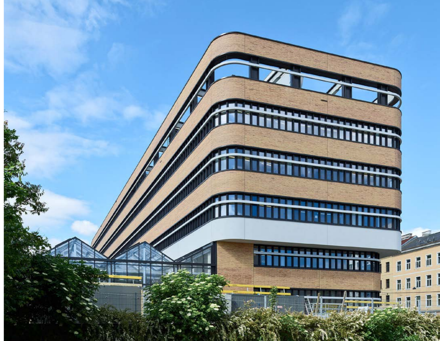
Biozentrum Universität Wien Campus-Vienna-Biocenter 4; © Liebner Backhaus
